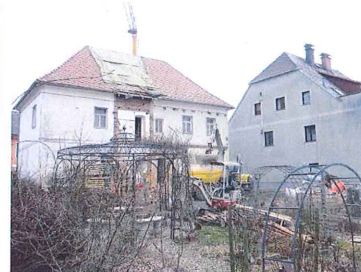
Eine umfassende Sanierung erfährt zurzeit das Gemeindeamt Hengsberg, das bis zum nächsten Jahr in neuem Glanz erstrahlen soll. Kindermann (2)
