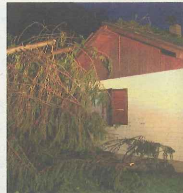
Einige beschädigte Gebäude hinterließ der Sturm „Gonzalo“.
