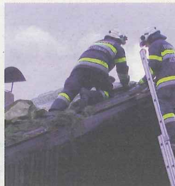
Die Feuerwehr-Kameraden dichteten provisorisch Dächer ab.
