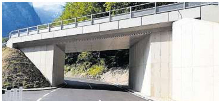
Neubau der Martauer Brücke sollte Nadelöhr entschärfen
